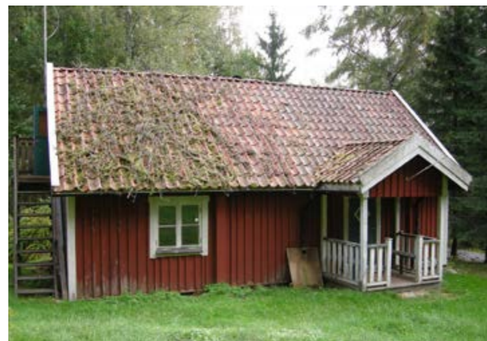
Figur 15. Fasaden mot väster med senare tillkommen förstukvist. I stort sett är nya tillskott anpassade till byggnadens karaktär.
