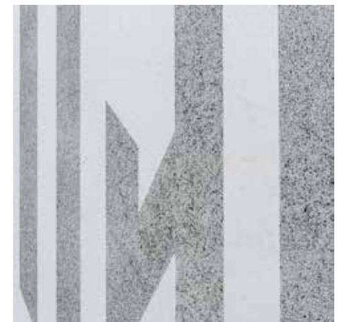
39. Exempel på grafisk betong. Graphic Concrete® DigiPlex Datacentre 9, Heiaveien, 1900 Fetsund, Norway Mad Arkitekter
