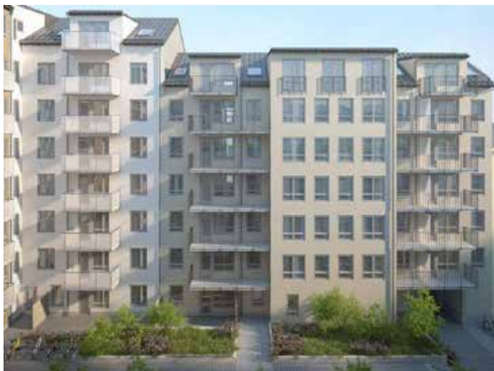
37. Fasadförskjutning, småskalighet i den stora volymen. Genom att förskjuta fasadlivet och alternera balkongutförandet skapas en känsla av småskalighet och rytm i en, egentligen, större byggnadsvolym.
