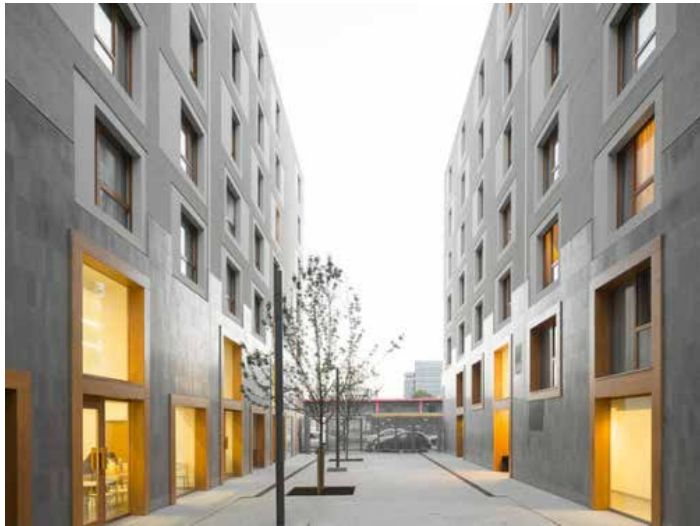
36. Bearbetning av betongyta skapar liv i fasaden. Atelier Fernandez & Serres - 2016 Lodgements, Marseille 2012.
