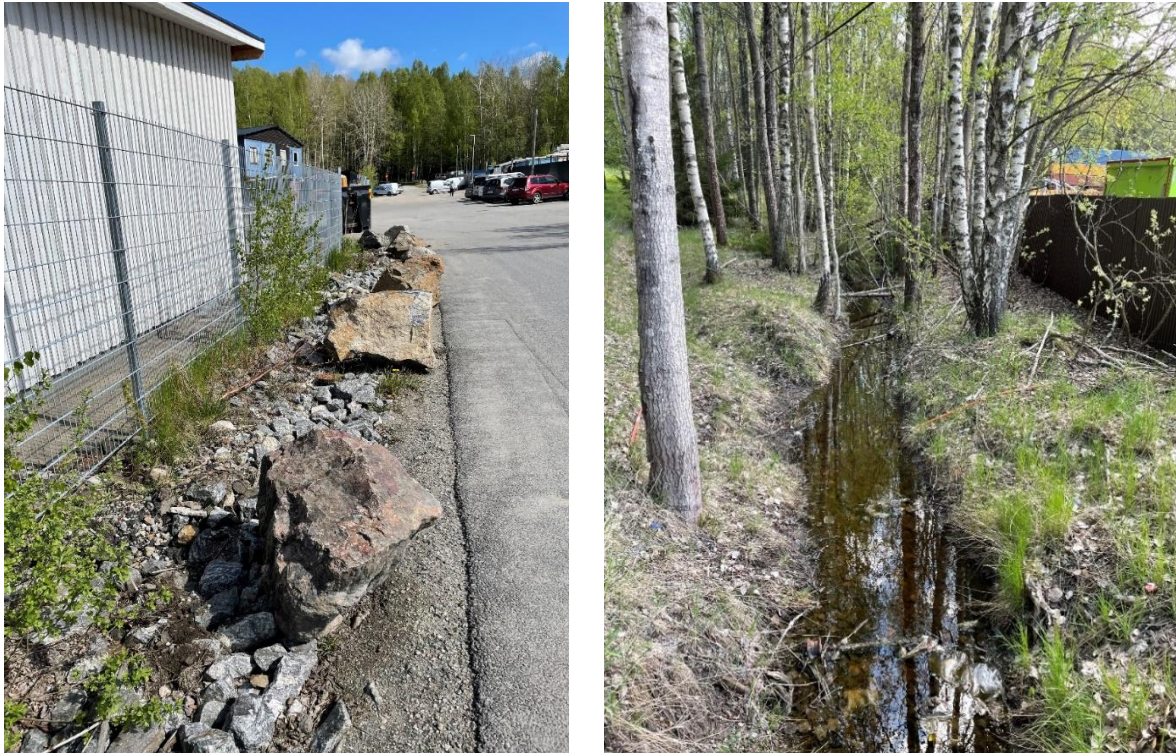
Figur 3.7. Bild till vänster: Stenlagt vägdike/vattendrag, delvis kulverterat, genom Bovallens industriområde. (Vy mot nordöst, mot Finkmosseberget.) Sträckning för vattendraget enligt kartunderlag från Länsstyrelsen. Bild till höger: Vattendrag runt Bovallens industriområdes södra sida. Sträckning ej redovisad i kartunderlag från Länsstyrelsen.
