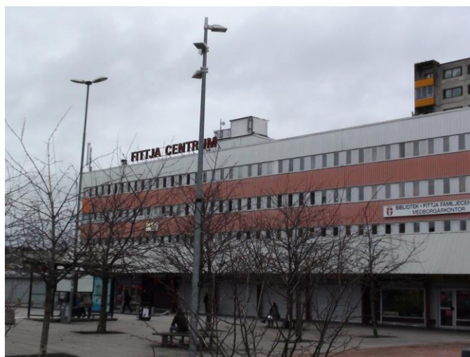
Vy från torget mot centrum och tunnelbanestation
