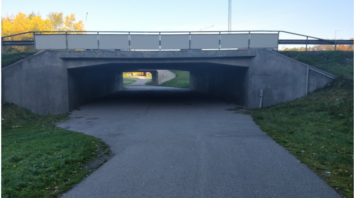
Figur 3.2. Befintligt gång- och cykelväg under E4 mot Fittja centrum. Stråket upplevs sannolikt av många som otryggt kvällstid pga sin ödsliga omgivning och gångtunnlar med begränsade flyktvägar.
