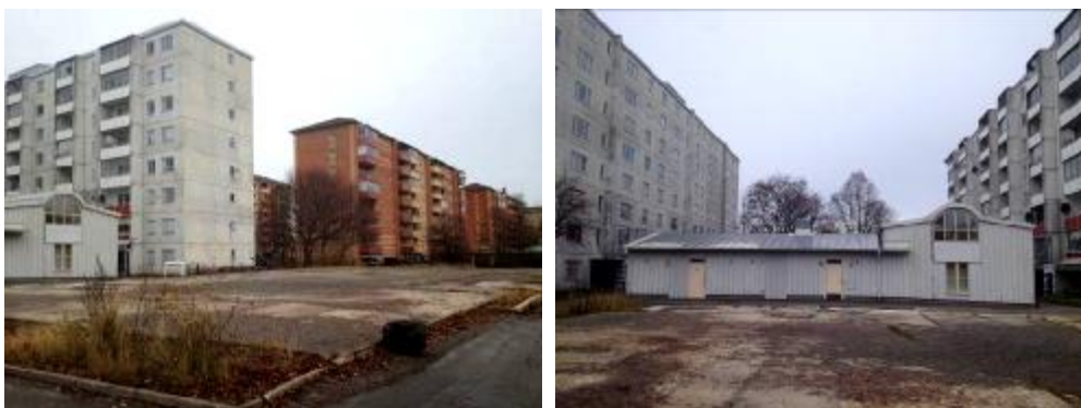
Befintlig bostadsbebyggelse i åttavåningar.
