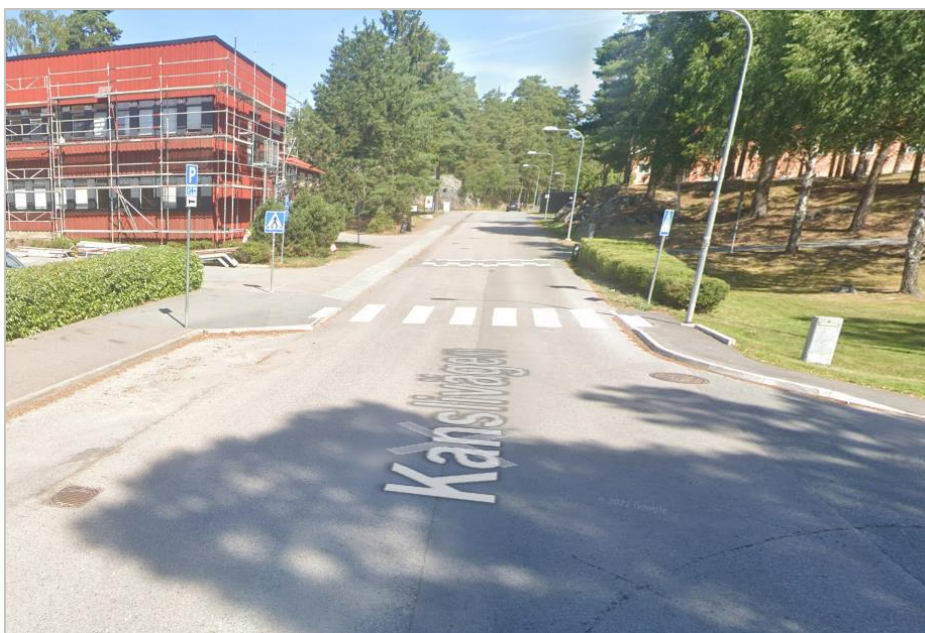
Figur 5. Exempel på gång- och cykelväg med vägmärken i körbanan som försämrar framkomligheten.
