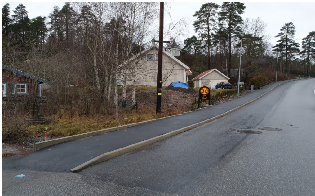
Kästadalsvägen ny gångbana
