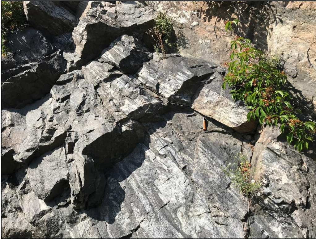
Figur 2. Bergskärning vid förskolan. I bilden övre högra del syns en svag rostfärgning medan övrigt berg är till synes friskt.
