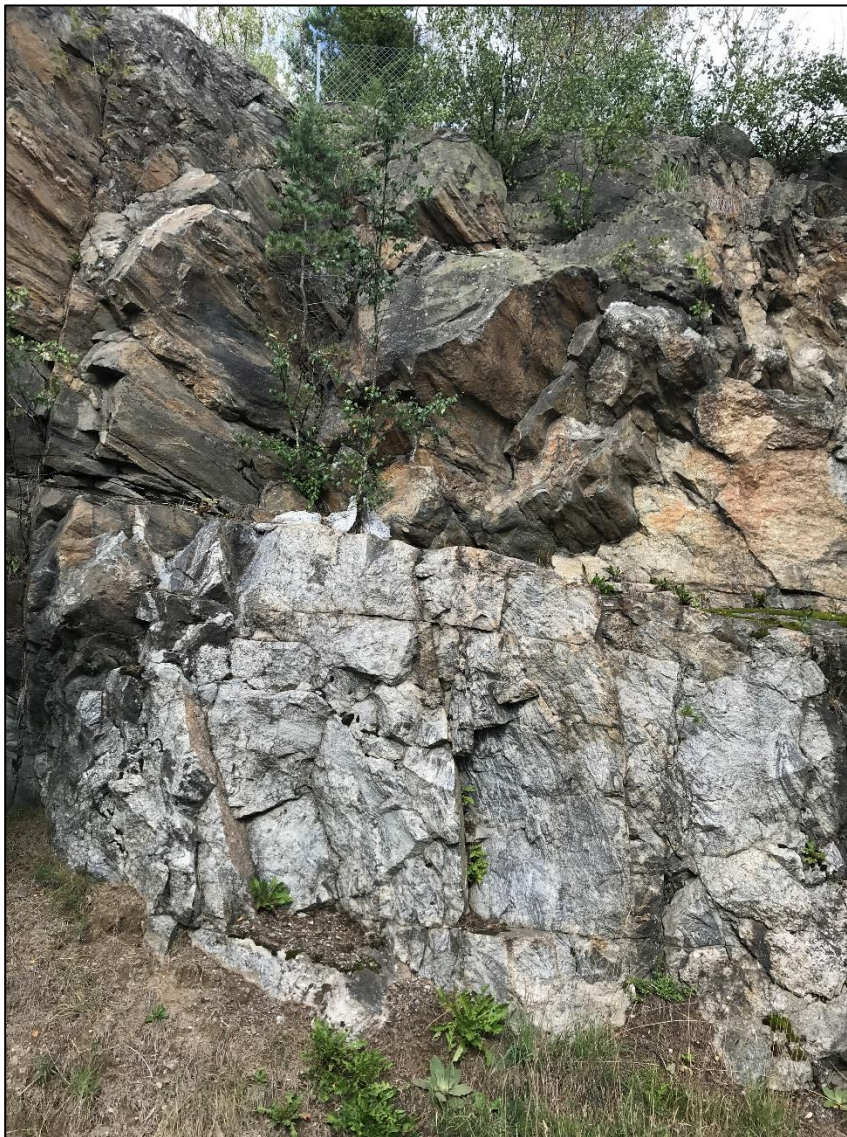
Figur 3. Skärning längs Harbrovägens norra sida i områdets östra del. Berget består dels av en ljus frisk bergart, dels av en rostfärgad lätt ytvittrad bergart.
