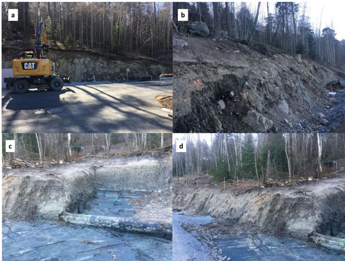
Figur 4. Bild av jord i schakt vid pågående markarbete vid Bryggarvägen, vy upp mot slänten för planerad bebyggelse (2019-02-04).
