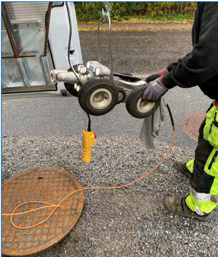
Bild 9. Filmning av spillvattenledning är en del av arbetet för framtagande av VAs förnyelseplan. Foto: Mikael Lindroos
