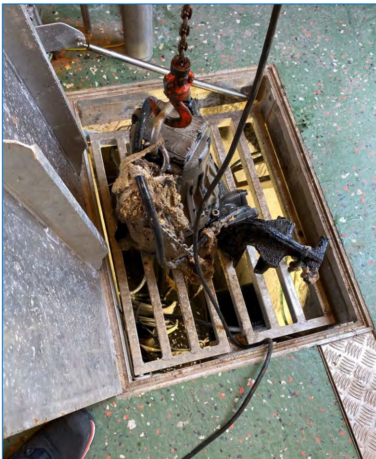
Bild 4. Träskor, blöjor, våtservetter, bindor med mera som har spolats ner i toaletten har orsakat stopp i avloppspumpen. Foto: Mikael Lindroos
