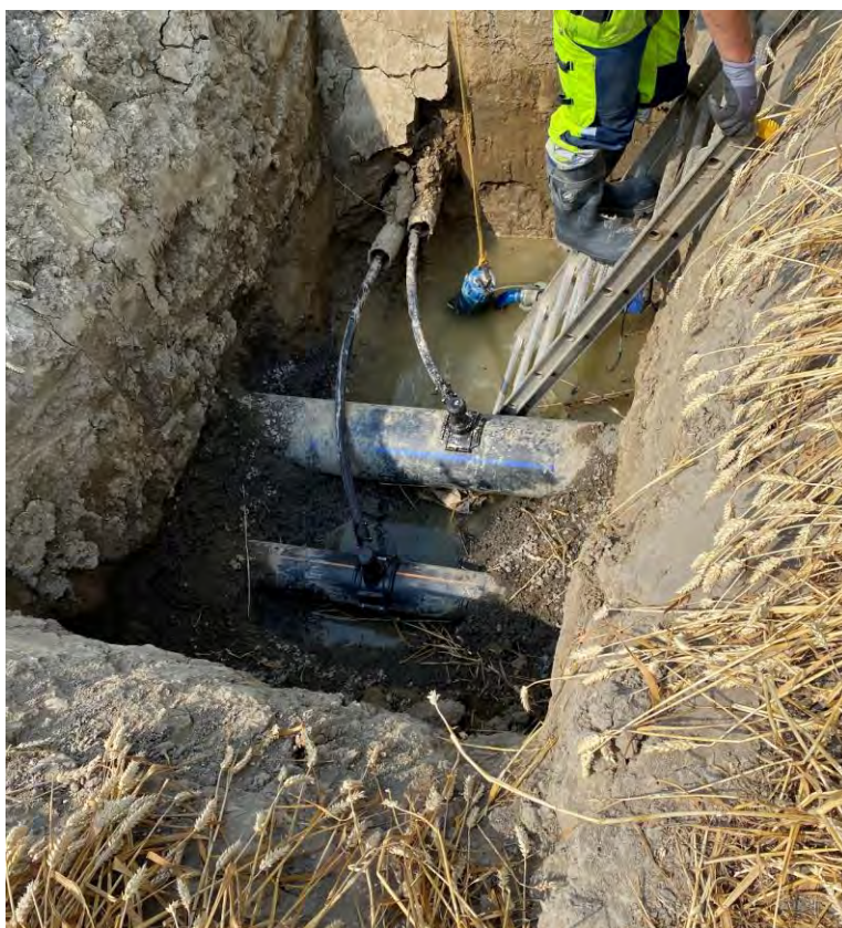
Bild 1. Arbete med inkoppling av nya serviser för avlopp och vatten på befintlig huvudledning. Foto: Mikael Lindroos.
