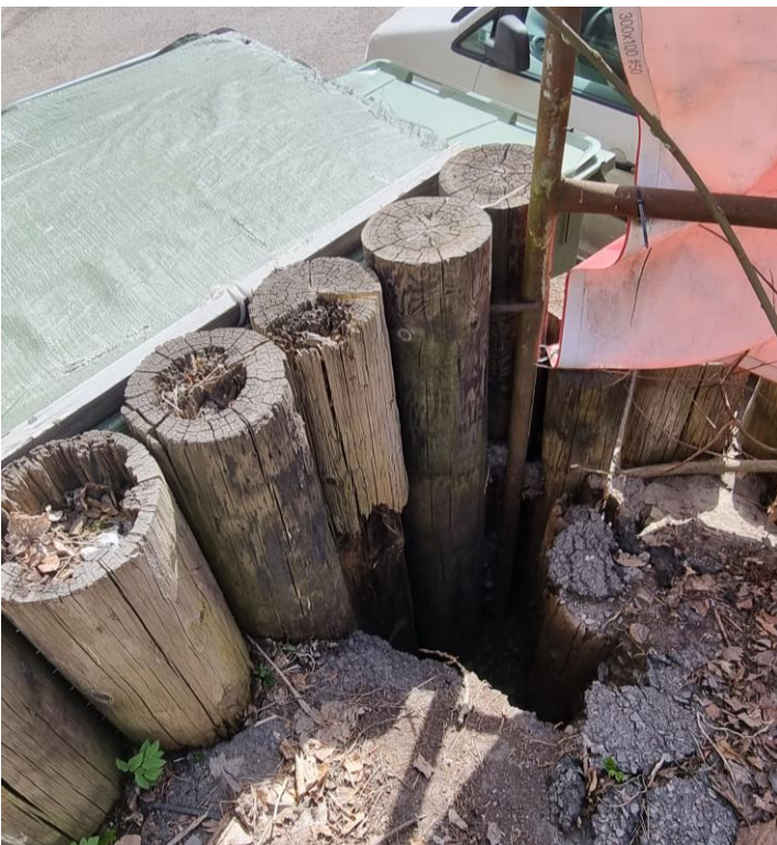
Figur 9 Stödmuren bakom parkeringen, däckverkstadens västra sida.
