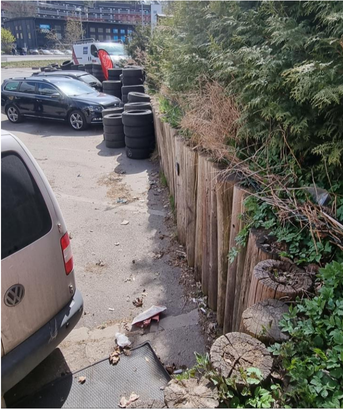
Figur 8 Stödmuren bakom parkeringen, däckverkstadens västra sida.
