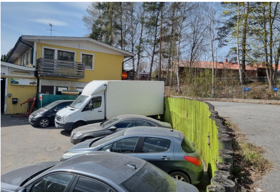
Figur 7 Stödmur för höjdskillnaden bakom parkeringen, östra sidan av däckverkstaden.
