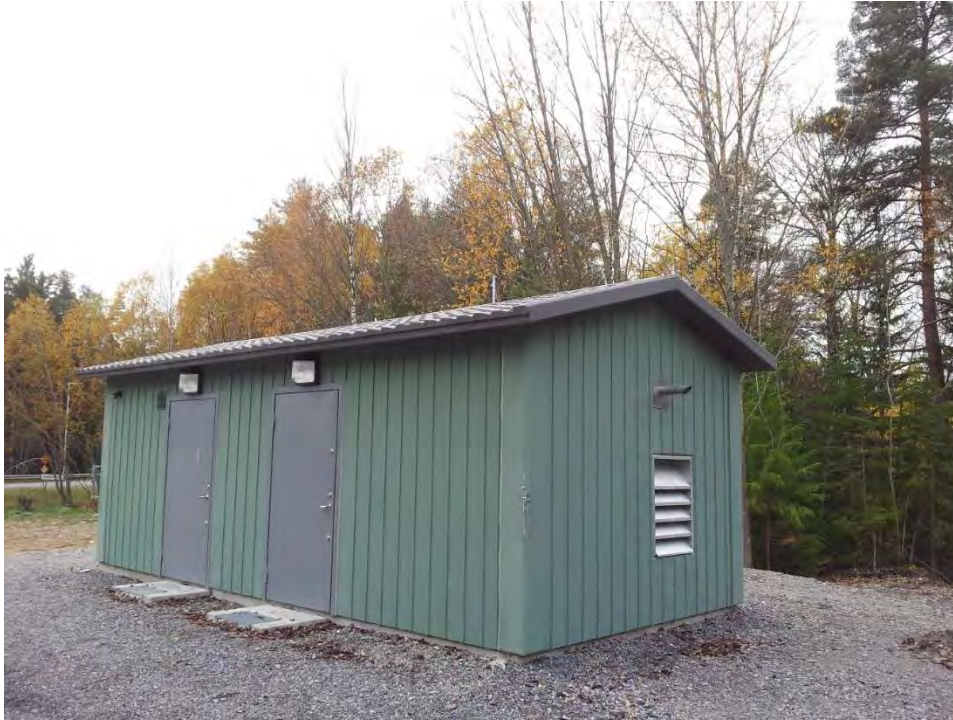
Bild 6 . Avloppspumpstation med överbyggnad och reservkraft (Botkyrka kommun).
