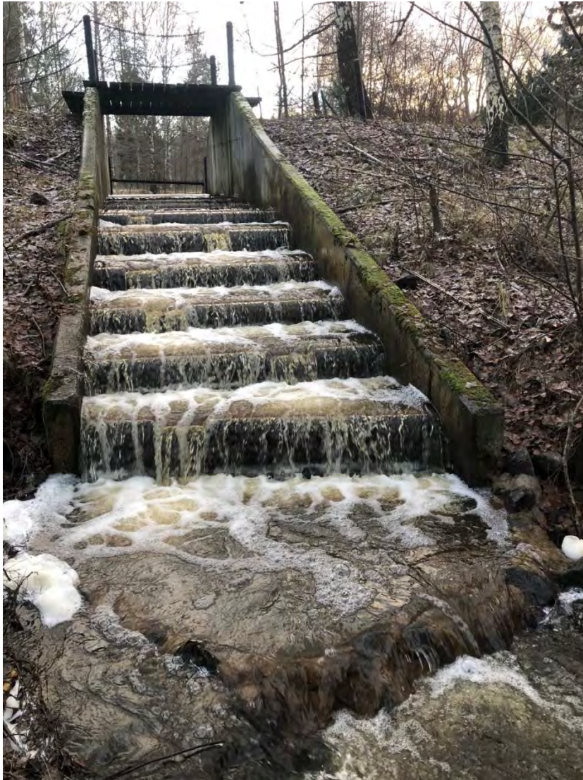
Nygjord fisktrappa nedströms branddamm i Harbrobäcken, december 2018.
