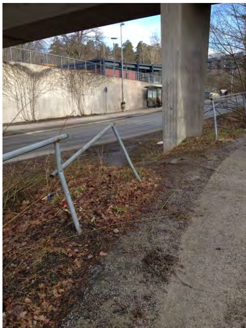
Bild 12. Informell passage över Tingsvägen.
