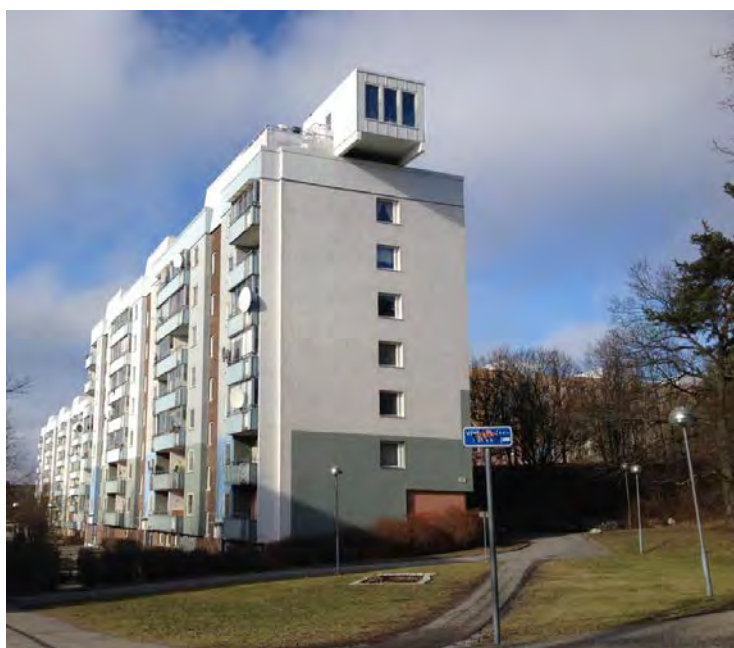
Bild 4. Nyttillkommen påbyggnad på befintlig bebyggelse.
