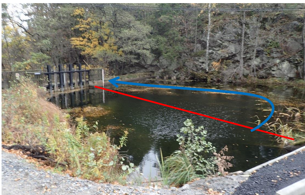
Figur 30. Den planerade fiskvägen (blå linje) anläggs mellan en ny spontvägg (röd linje) och den högra stranden. Norconsult 2016.
