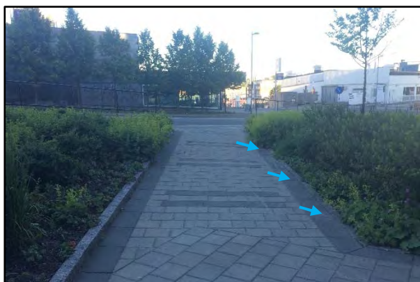
Bild 12. Exempel på ytlig avvattning av gångväg skevad till nedsänkt växtbädd med kantsten utan visning.
