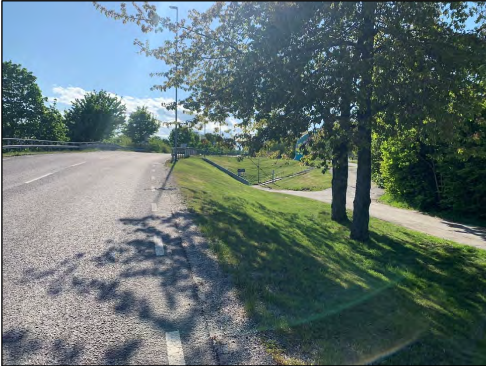
Bild 2. Dämningsyta 1, gångtunnel. Vy från öst. Albyvägen till vänster i bild.
