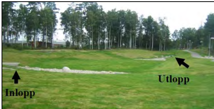
Bild 17. Exempel på utformning av multifunktionell grönyta. In- och utlopp har förstärkts med erosionsskydd. (Botkyrka kommun, 2021).
