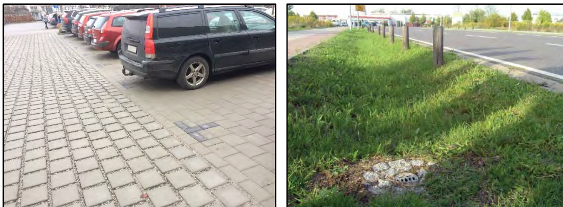
Bild 14 och 15. Till vänster tät parkeringsyta med skevning mot genomsläpplig infartsgata. Till höger skevning av hårdgjord yta mot nedsänkt vegetationsbeklädd infiltrationsyta (Stockholms stad, 2016).
